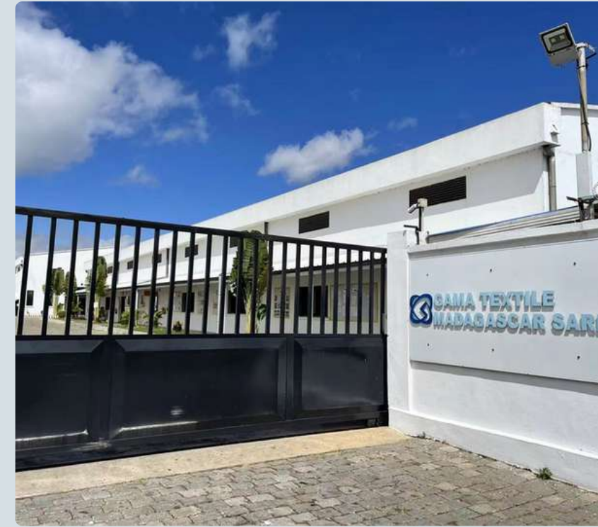
GAMA廠 安塔納利佛 75 Lines
