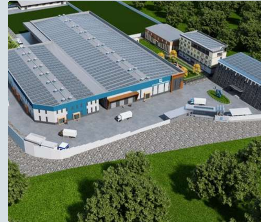
BAOBAB新廠 安塔納利佛 (建設中)
